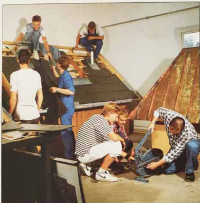
Øverst: Taginddækning med skiferplader, og til højre i billedet arbejder elever med at fæste et kobbertag.
